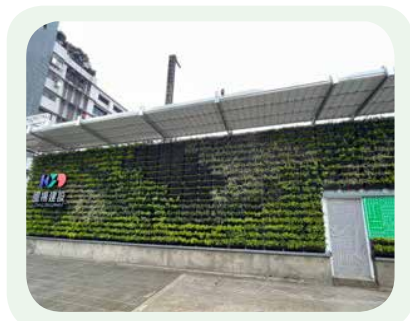
施工圍籬綠美化
