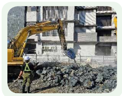
工區堆料棄土區灑水噴霧
