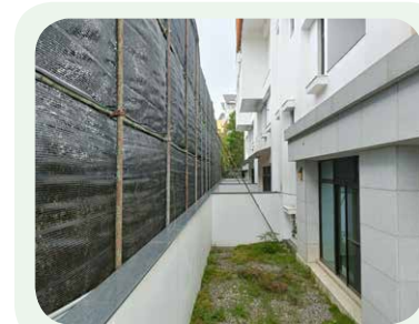
鄰房側與鄰房 翡翠森林四期之間架設防塵網
