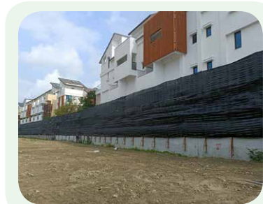
北向與鄰房 翡翠森林四期之間架設防塵網
