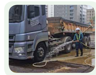
工區進出車輛清洗
