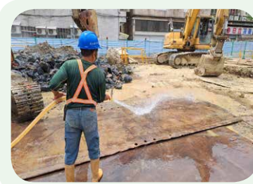
工地揚塵灑水
