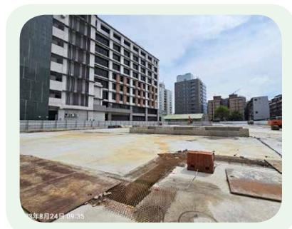
工區採混凝土路面降低粉塵
