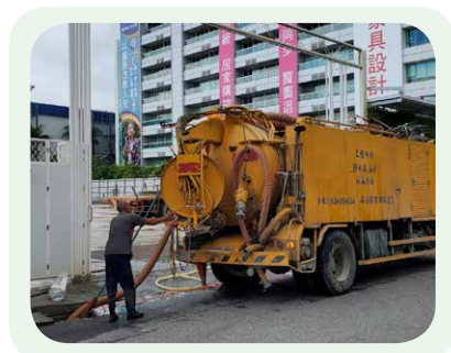
路旁水溝清洗
